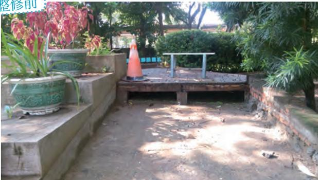
棧道下方腐朽嚴重為安全計先行拆除
